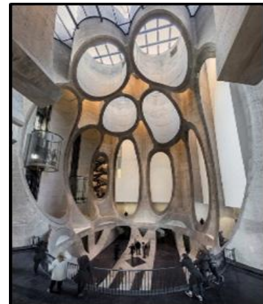
Atrium van die Zeitz MOCAA Die oorspronklike binnestruktuur van 56 styfgepakte, silindervormige beton-graansilo's is uitgekerf om die atrium te skep.
